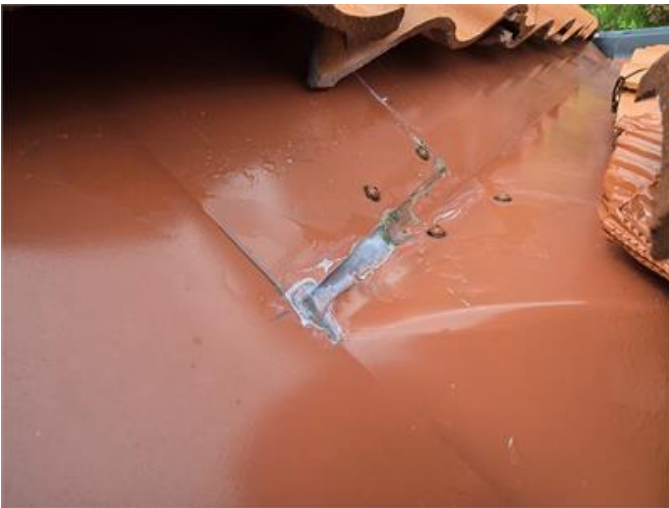
Tak: Infästningar samt tätningar i rännal.
