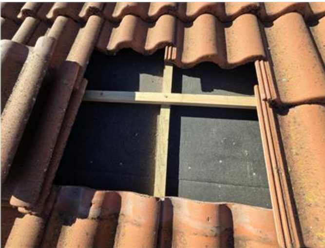
Tak: Stickprovskontroll under pannor utan anmärkning.
