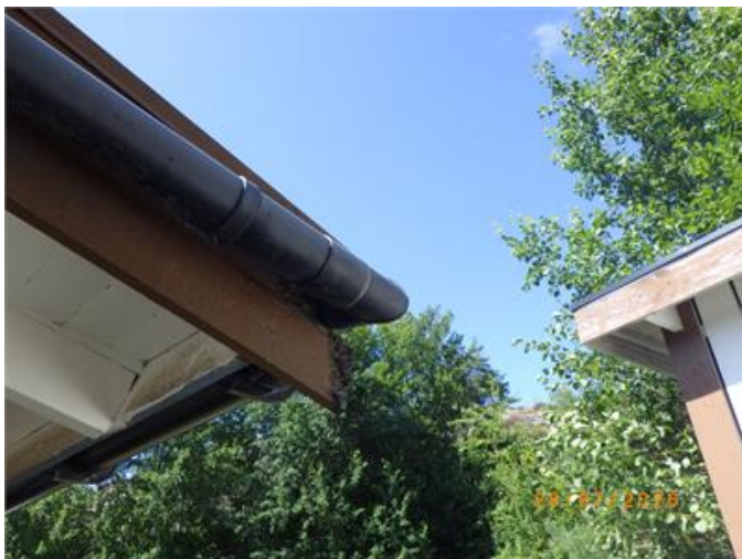
Stuprör på entrésidan avslutas i hänggränna med bakfall . Översiktsbild tak.
