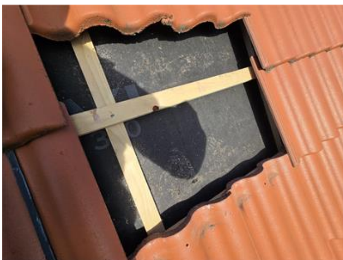
Tak: Stickprovskontroll under pannor.
