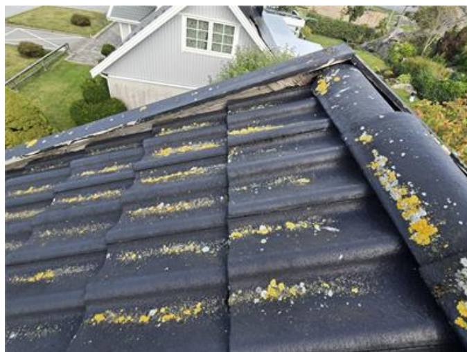
Tak: Mossa börjar få fäste lokalt, mindre otätheter mellan vindskivor/pannor.
