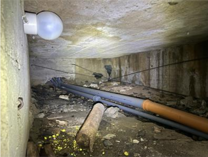
Utrymme under altanen på norrsidan: Översiktsbild.
