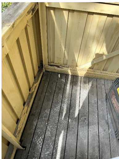
Ex på rötskador balkongräcken
