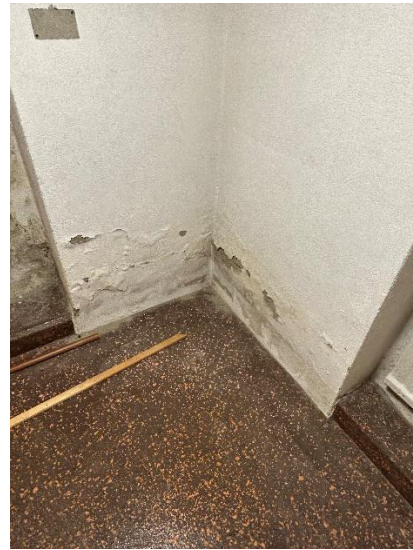
Ex på fuktinträngning utifrån – puts o färgsläpp förekommer nertill på källarväggarna
