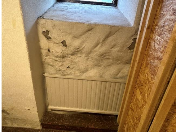
Ex på fuktinträngning utifrån – puts o färgsläpp förekommer nertill på källarväggarna
