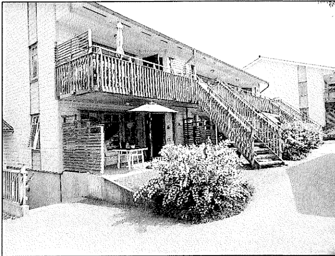
Bild 5 Fasad av träpanel och fibercementskivor
