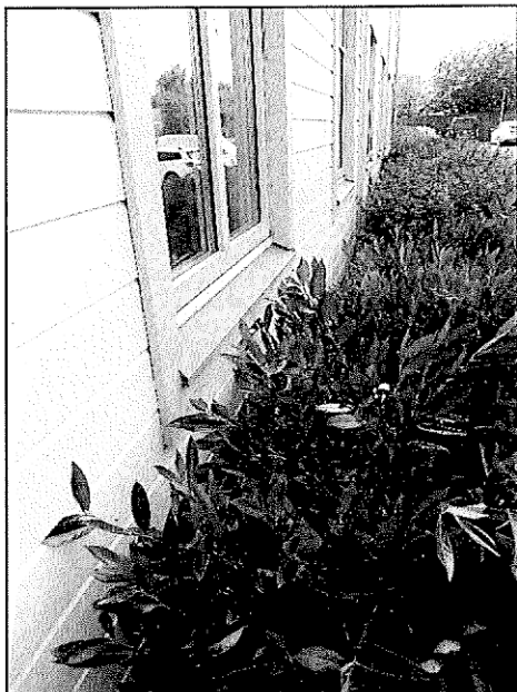
Bild 1 Växtlighet mot fasad
