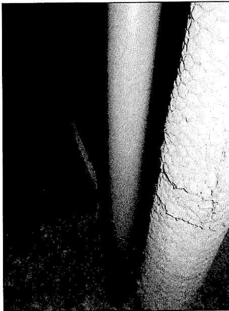
Bild 19 Spillvattenrör på vind
