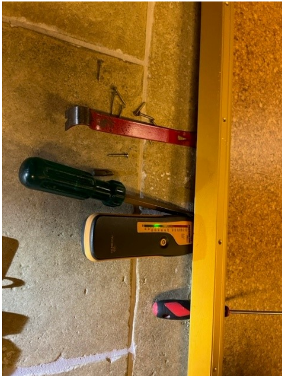
Fuktmätning i sidan av golvspånskiva i hobbyrummet.
