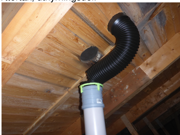
Vind, avluftningsrör.
